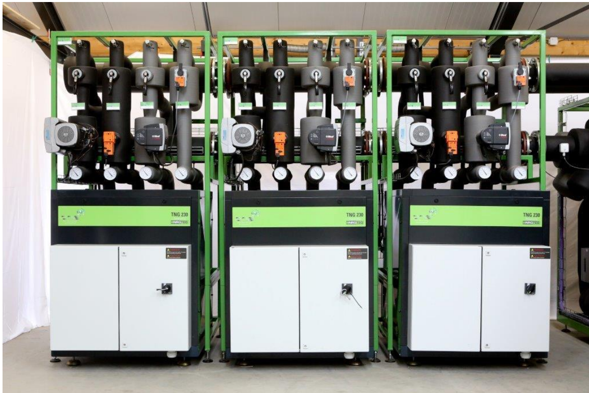
3x 230 kW warmtepomp geprefabriceerd met circulatiepompen en overige randapparatuur
